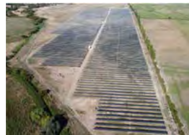
Proyecto La Palma Solar, Comuna de Chillán, 9MW/ac
