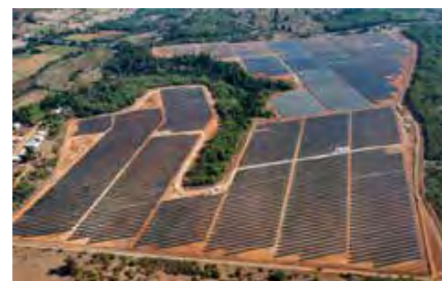
CARBONFREE Proyecto: Parques fotovoltaicos Chillan I & II Potencia instalada: 10MW (x2)mundial.
